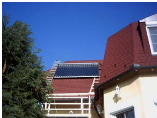
4-5.sz. kép a napkollektorok szerelési munkálatai
