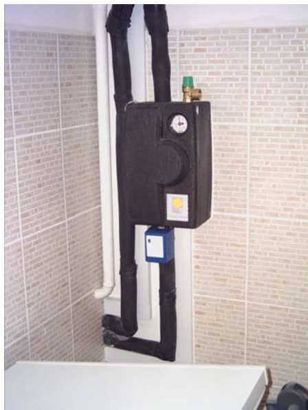
7.sz.kép Solar hidraulikai egység
