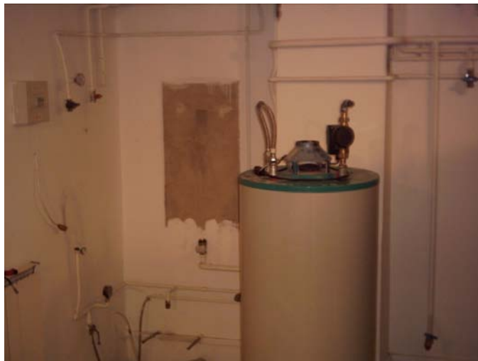
2.sz. kép a meglévő berendezések bontása
